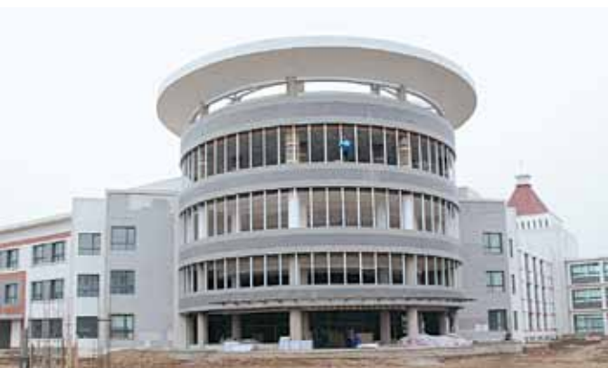
Pampigt värre. Det nya barnhemmet byggs i Pingliang.
